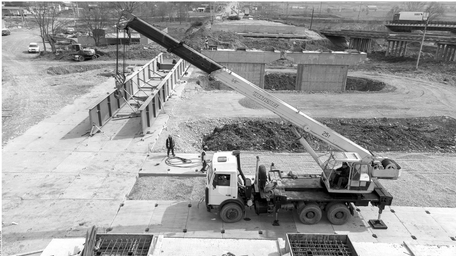
Идет установка металлоконструкций
